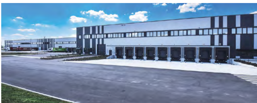
Nachhaltiges Bauen mit Stahl, hier das Logistikzentrum EXETER in Leipzig-Gröbers
